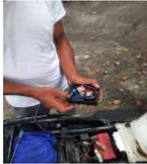
Gambar 11 Menghubungkan Kabel Kontak Pada Relay
