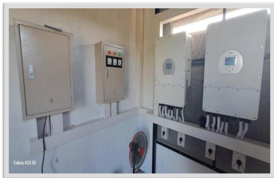
Gambar 7. Panel Inverter dan baterai Lifepo4
