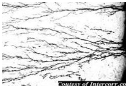
Gambar 2. 5 korosi tegangan Sumber:(Utomo, 2009)
