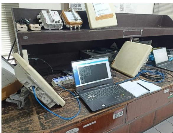
Gambar 1. Rangkaian sederhana pemasangan fisik Radio link PTP 58300
